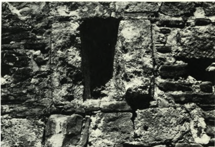
β. "Αγιος Λέων Μεθώνης. Ύπολείμματα συμφυῶν κισνοκράνων κιλλιβαντοειδῶν κίονων.
