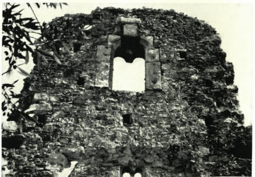
β. "Αγιος Λέων Μεθώνης. Ἐξωτερικὴ ὄψις τοῦ νοτίου τυμπάνου τῆς ἐγκαρσίας καμάρας. Χαμηλά, διὰ μέσου ἀκανονίστου ἀνοίγματος, φαίνεται τὸ βόρειον τύμπανον.
