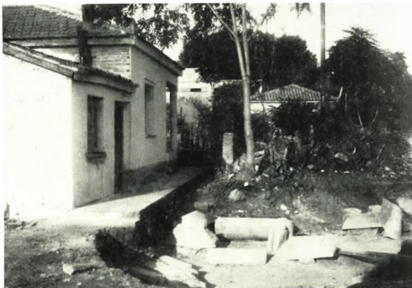
β. 'Ο Τομέας Ε κατά την έναρξιν τής σκαφής.
