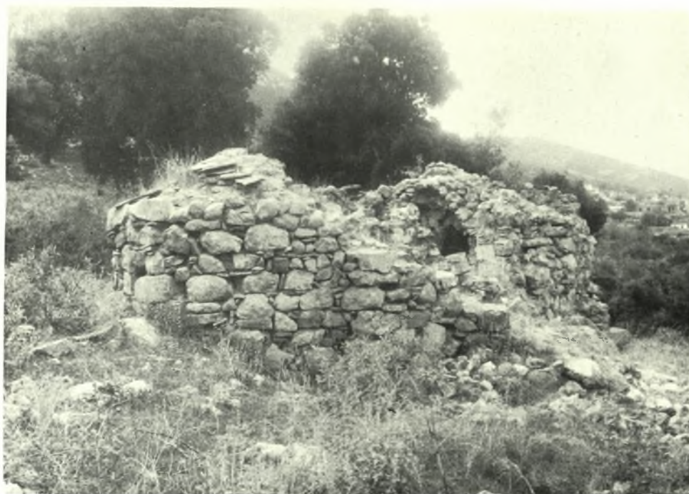
Βοιωτία : α. Μονή Σκριποῦς. Ἡ Ν. πλευρά τῶν παλαιῶν κελίων μετὰ τὰς ἐργασίας, β. Τὰ ἐρείπια τοῦ ναΐσκου τοῦ Ἁγίου Νικολάου
