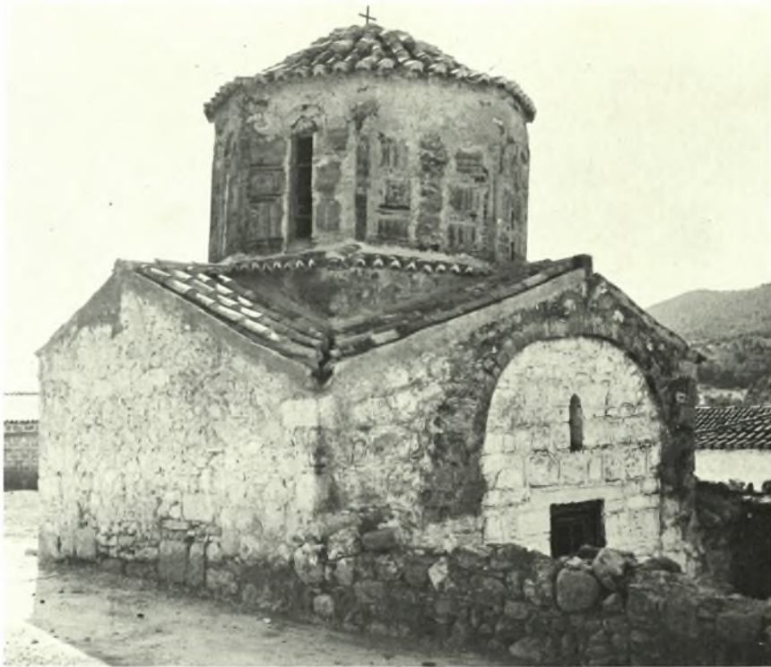
Ἀττική. Συκάμινον: α - β. Ὁ ναὸς τῶν Ἁγίων Τεσσαράκοντα ἀπὸ ΒΔ., πρὸ καὶ μετὰ τὰς ἐργασίας
