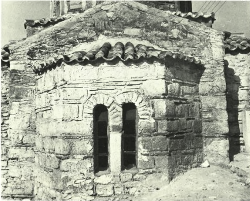
Ἄττική. Συκάμινον : α. Ναός Κοιμήσεως τῆς Θεοτόκου. Ἡ Πλατυτέρα, β. Ναός τῶν Ἁγίων Τεσσαράκοντα. Τὸ ἱερόν μετὰ τὰς ἐργασίας
