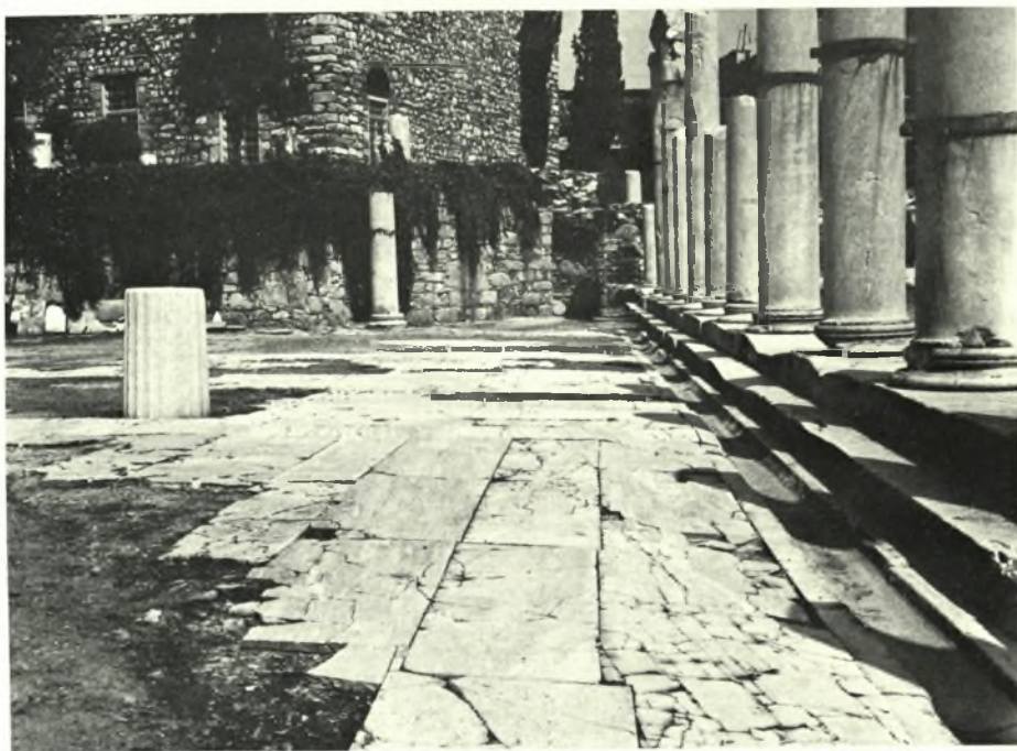
*Αθήναι: α. Ἡ Ν. κιονοστοιχία τῆς βασιλικῆς τῆς Βιβλιοθήκης Ἀδριανοῦ, β. Τὸ δάπεδον τῆς αὐλῆς τῆς Ρωμαϊκῆς Ἀγορᾶς μετὰ τὰς ἐργασίας στερεώσεως
