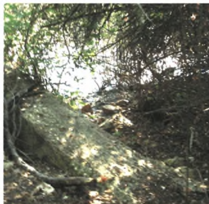
Εικ.6β: Σταθμός 2- Φράγμα
