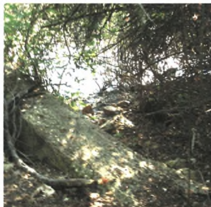
Εικ.6β: Σταθμός 2- Φράγμα
