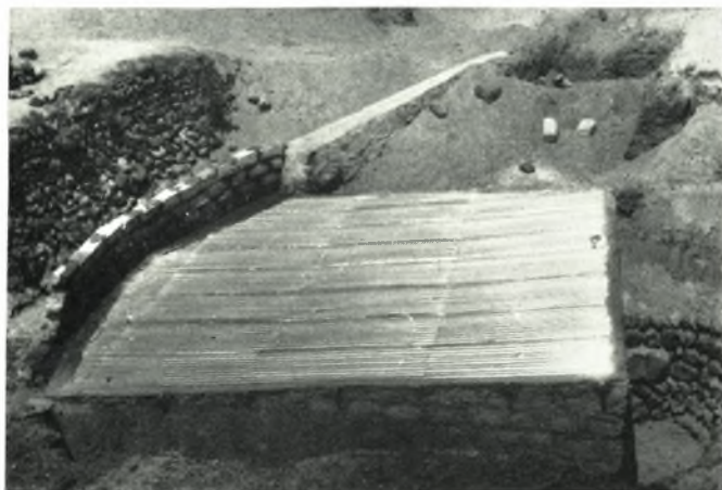
γ. Τὸ ἀνασκαφέν τμήμα τῆς ἀποθήκης μετὰ τὴν στέγασιν.
