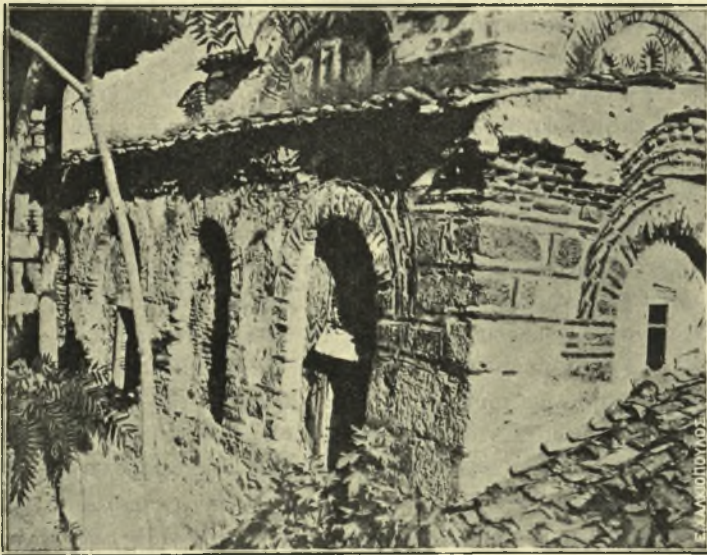
Εἰκ. 7. Ἡ νοτιὰ πλευρὰ τοῦ Καθολικοῦ μετὰ τῶν ἀψιδωμάτων.
