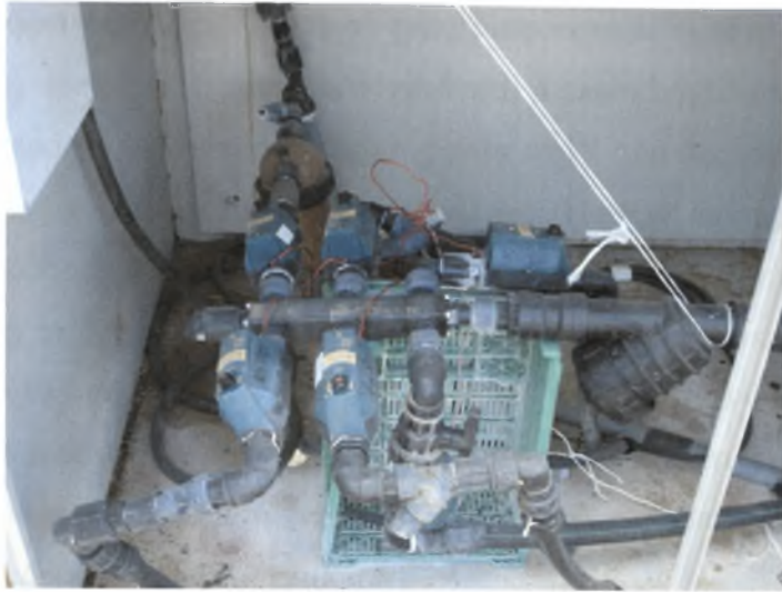
Εικόνα 3.5 Ηλεκτροβάνες
