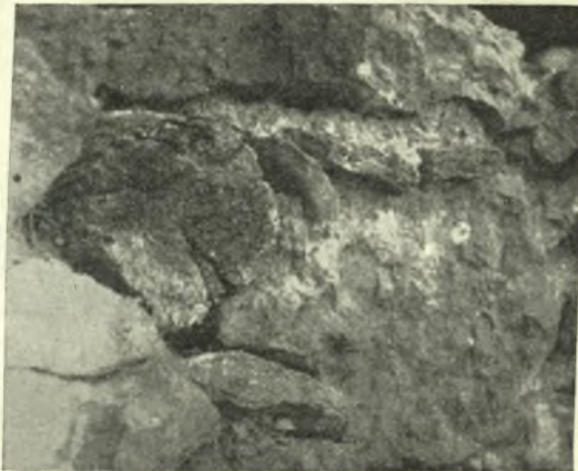
Εἰκ. 16. Ἴχνη ξυλοδέσμου κατὰ τὴν Δ πλευρὰν τοῦ ἀναλημματικοῦ τοίχου τοῦ ναοῦ τῆς Ἀναλήψεως Τσιπιανῶν.
