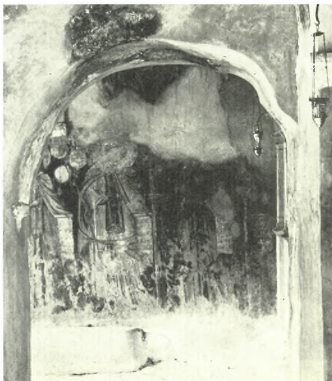
Κριτσά. Παναγία ή Κερά: α. Νότια όψη νοτιοδυτικού ανοίγματος ( Δ ), β. Νότια όψη βορειοανατολικού ανοίγματος ( Α )
