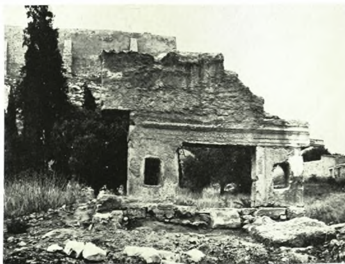
Ἄθῆναι. Περιοχὴ κατεδαφίσεων ΝΑ. τοῦ Διονυσιακοῦ θεάτρου: α. Ἐνωτὸν τμήμα ἐνεπιγράφοῦ στήλης μετὰ κατάλογον ὀνομάτων, β. Μεσαιωνικὴ πύλις ἐξ ἀρχαίου ὑλικοῦ
