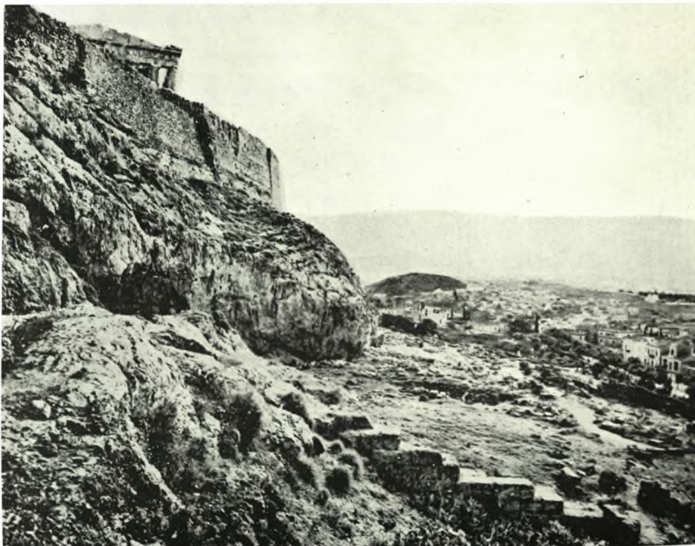
Ἄθῆναι: α. Τὸ Φετιχιέ-Τζαμί μετὰ τὴν ἐξωτερικὴν του διαμόρφωσιν, β. Ὁ Δ. τοῦ Ἀσκληπείου χώρος, πρὸ τῆς διαμορφώσεως, κατὰ παλαιὰν φωτογραφίαν
