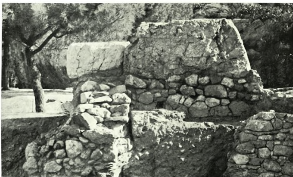
Ἀθήναι: α. Τμήμα τοῦ καλουμένου «Πελαργικοῦ» μετὰ τὴν διαμόρφωσιν, β. Γωνία προϊστορικοῦ οἰκοδομήματος ὑπὸ τὸ διασωζόμενον τμήμα τοῦ καλουμένου «Πελαργικοῦ»
