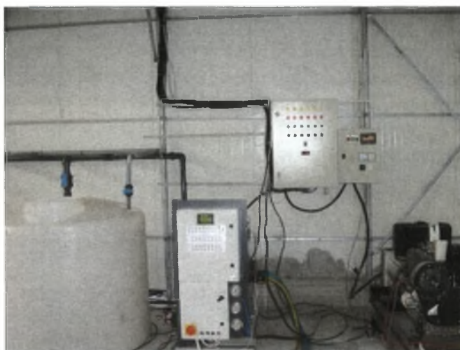
Σχήμα 1.2.3. Σχηματική απεικόνιση συστήματος παρασκευής θρεπτικού διαλύματος.
