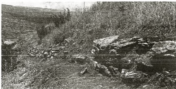
85. Λακέρεια Παλαιοκάστρου. Τμήμα τείχους
