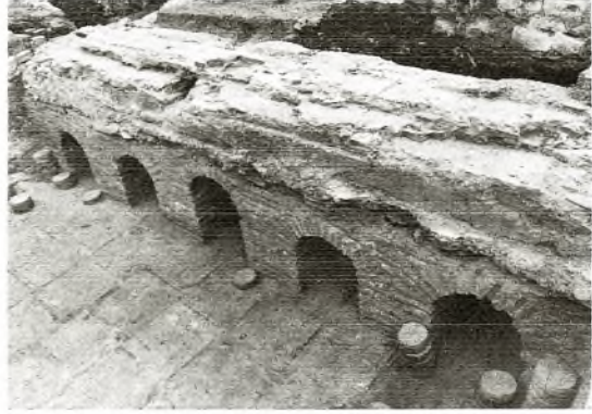
12. Λάρισα. Οικόπεδο στην οδό Μεγάλου Αλεξάνδρου 4. Άποψη του συγκροτήματος ρωμαϊκού λουτρού (Διαμέρισμα Β)
