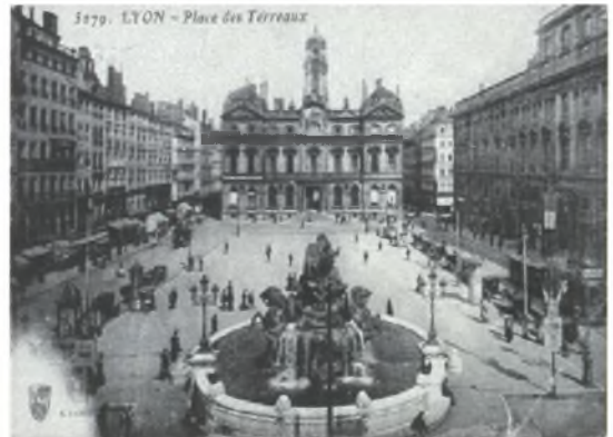
Εικόνα 21: Η Place des Terreaux στην αρχική της μορφή. (Πηγή: www.lyonphotos.com/diaporama/moyenne_1418.htm )
