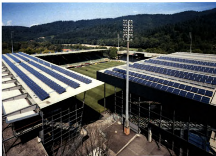
Εικόνα 6. Εθνικό γήπεδο ποδοσφαίρου. (πηγή : www.roheline.ee/files/energia/worner.pdf )
