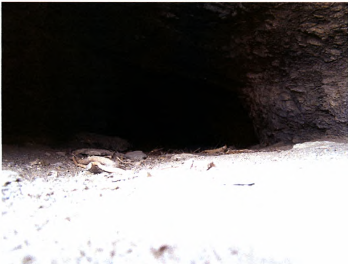
Εικ. 36: Δεύτερο τμήμα σήραγγας στο Βρυόκαστρο
