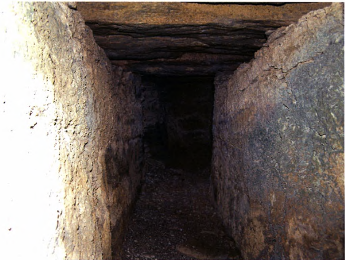
Εικ. 43: εσωτερικό διπλής καμπής. Λήψη από ΒΑ
