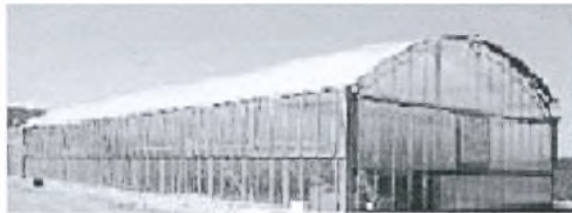
Σχήμα 23: Το θερμοκήπιο, όπου έγινε η δοκιμή.
