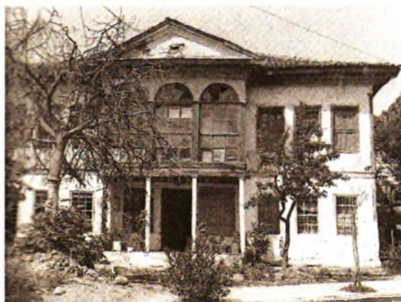
30. Οικία με υαλωτό χαγιάτι και αέτωμα- η λεγόμενη «Βίλα Λαχτάρα» (κατεδαφισμένη σήμερα), στην περιοχή της παλιάς συνοικίας Καραγάτς. Βρισκόταν στην συμβολή των οδών Αδριανού και Καλλιάρχου. Φωτογραφία Τ. Τλούπα [Γουργιώτης 2000]
