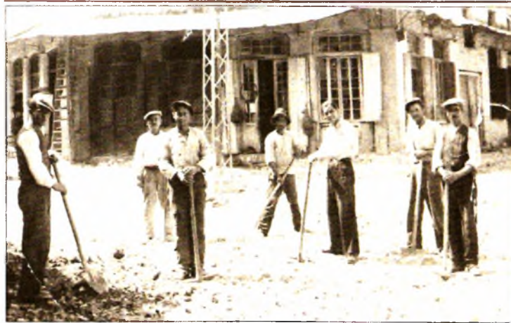
34. Εργάτες του δήμου στρώνουν με χαλίκι κεντρικό δρόμο των Τρικάλων (1930). Προφανώς η ίδια εικόνα ίσχυε και για τους δρόμους της γειτονικής Λάρισας [Κλιάφα 1983]
