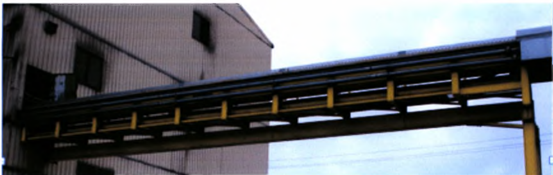
Εικόνα 4.2 Ενδεικτική μεταλλική κατασκευή προστασίας
