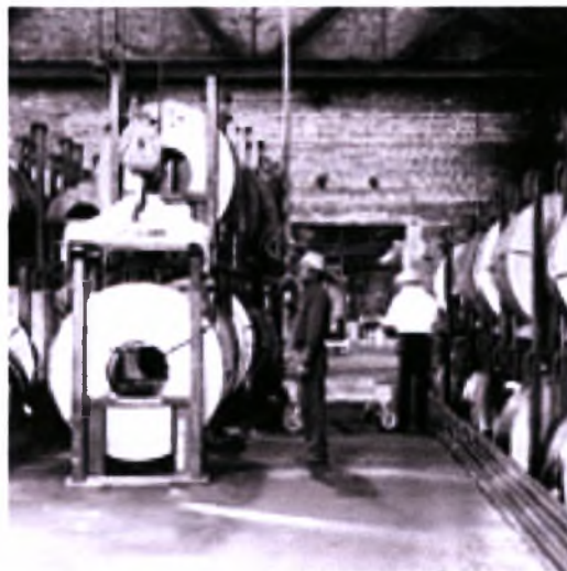
Εικόνα 4.13 Εφαρμογή διάταξης σε βιομηχανικό χώρο
