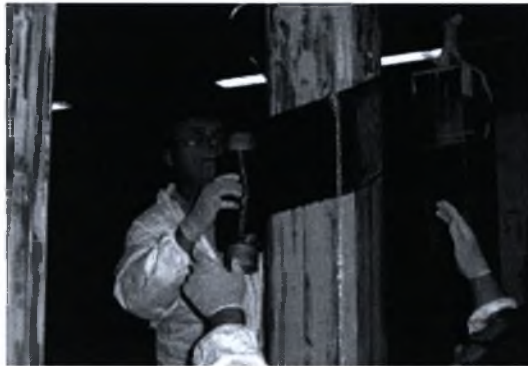
Σχήμα 1.5: Τοποθέτηση υφάσματος FRP
