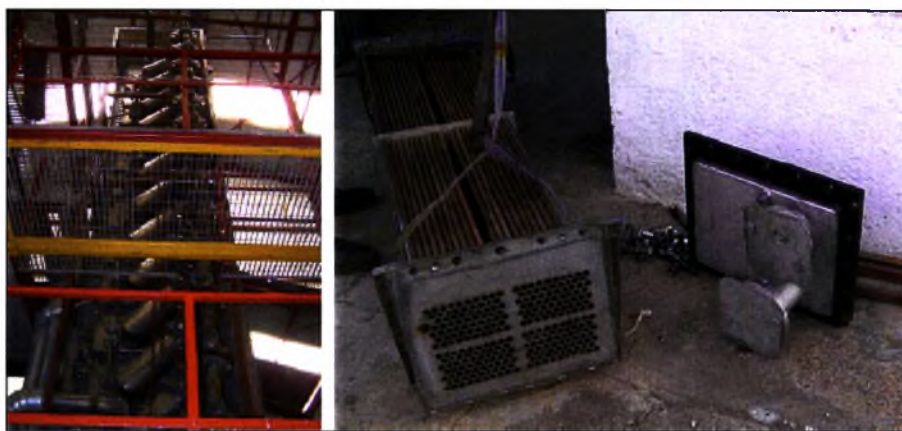
Εικόνα 2.4.2: Αριστερά η μονάδα PSA MED κατακόρυφης διάταξης και δεξιά η δέσμη με τους οριζόντιους αυλούς που αντικατέστησαν την πρώτη βαθμίδα (effect). [Πηγή: Blanco & Alarcon]
