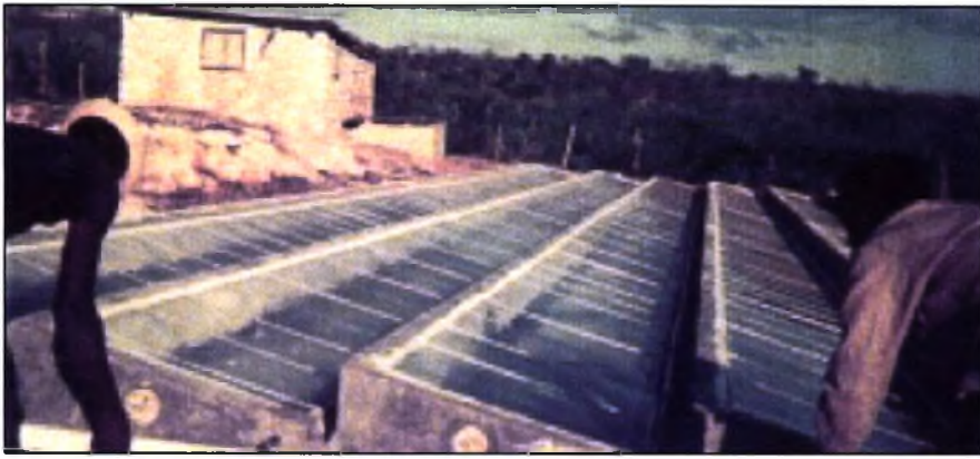
Εικόνα 2.3.1: Ηλιακός αποστακτήρας στην Αϊτή. [πηγή: Brace Research Institute]
