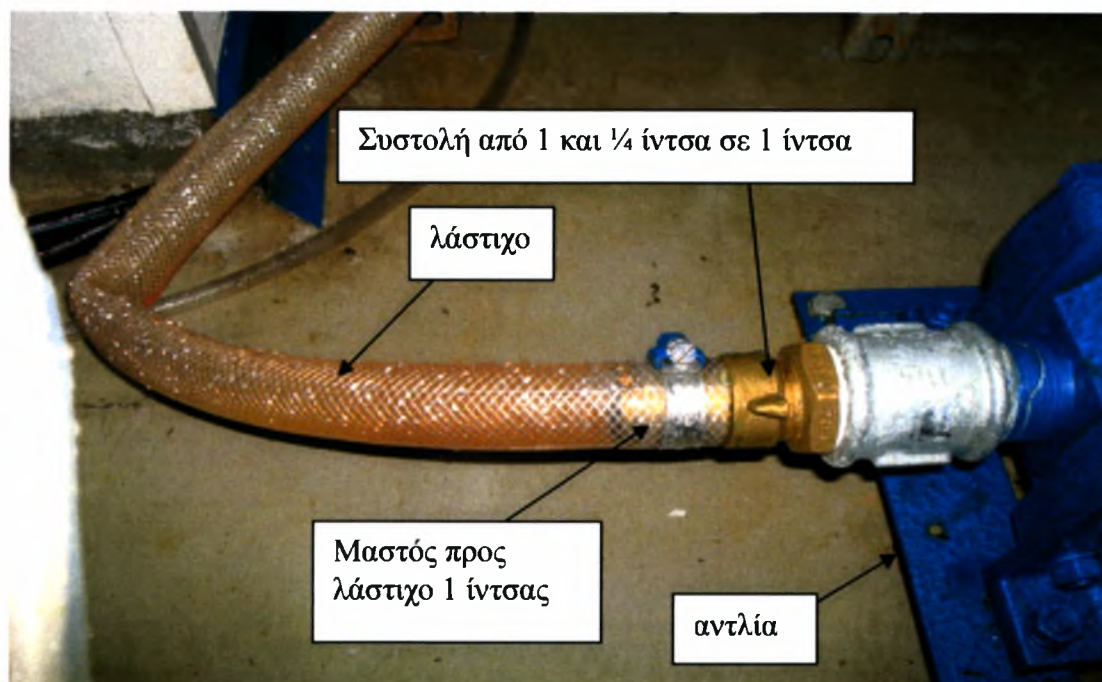
εικόνα 3.10. Σύνδεση αντλίας με τη “μεγάλη” δεξαμενή
