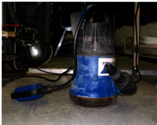
Σχήμα 3.8: Εμβαπτιζόμενη αντλία
