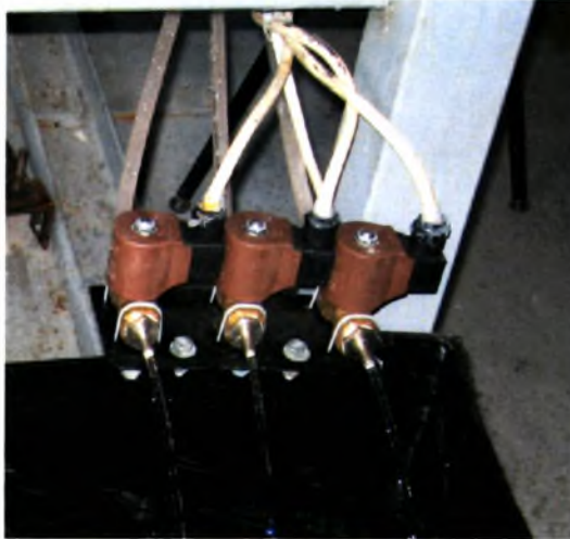
Σχήμα 3.9: Το σύστημα ηλεκτροβαλβίδων
