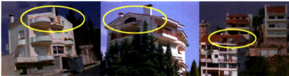
Εικόνα 1: Αυθαίρετες κατασκευές κάτω από επικλινείς στέγες
