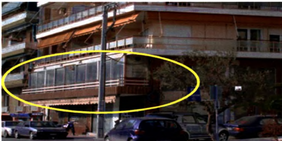
Εικόνα 4: Παράνομη ανέγερση κατασκευής σε μπαλκόνι
