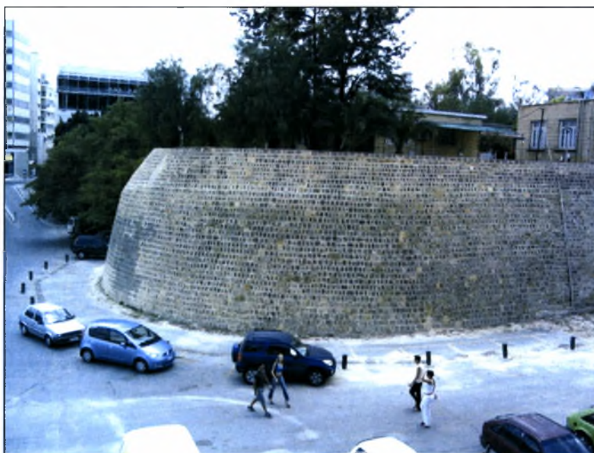
Εικόνα 32: Άποψη από Τάφρο και Προμαχόνα των Ενετικών Τειχών
