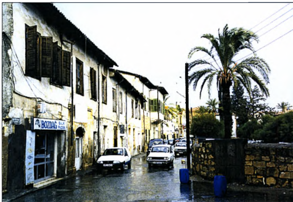
Εικόνα 31: Παραδοσιακά Κτίρια που βρίσκονται σε Κακή Κατάσταση
