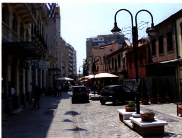
Εικόνα 26. Αποψη της οδού Κατούνη από την οδό Τσιμισκή. Διακρίνονται στα αριστερά τα διατηρητέα κτίρια της Τράπεζας Μακεδονίας – Θράκης
