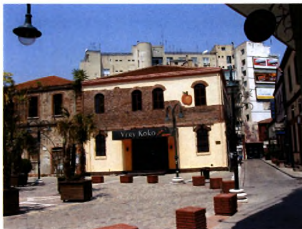
Εικόνα 21. Άποψη κτιρίων της πλατείας Μοριγόβου
