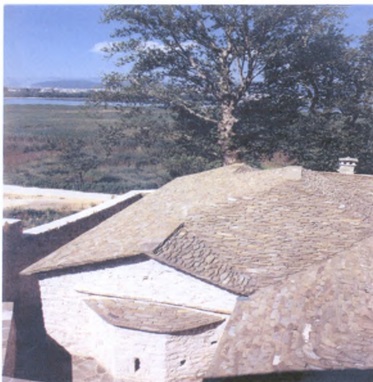
Εικ.19. Μονή Ελεούσης. Άποψη του ανατολικού τοίχου.
