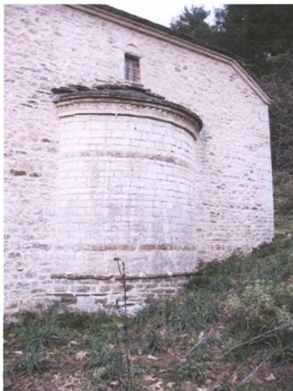
Εικ.31. Μονή Μεταμορφώσεως. Άποψη ανατολικού τοίχου και αψίδας.
