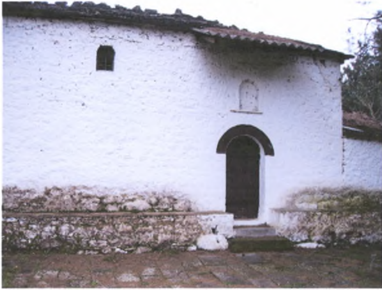
Εικ.21. Μονή Προφήτου Ηλίου. Άποψη του δυτικού τοίχου.
