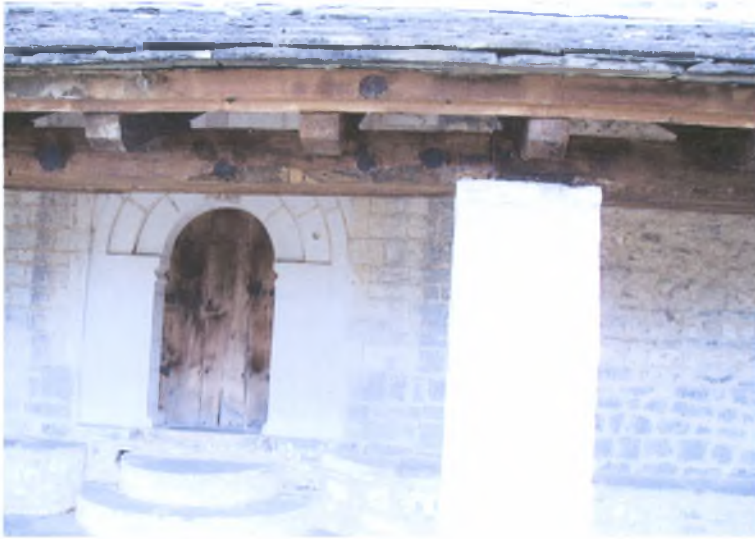
Εικ.33. Μονή Μεταμορφώσεως. Άποψη του νότιου μακρού τοίχου και του χαγιατιού.
