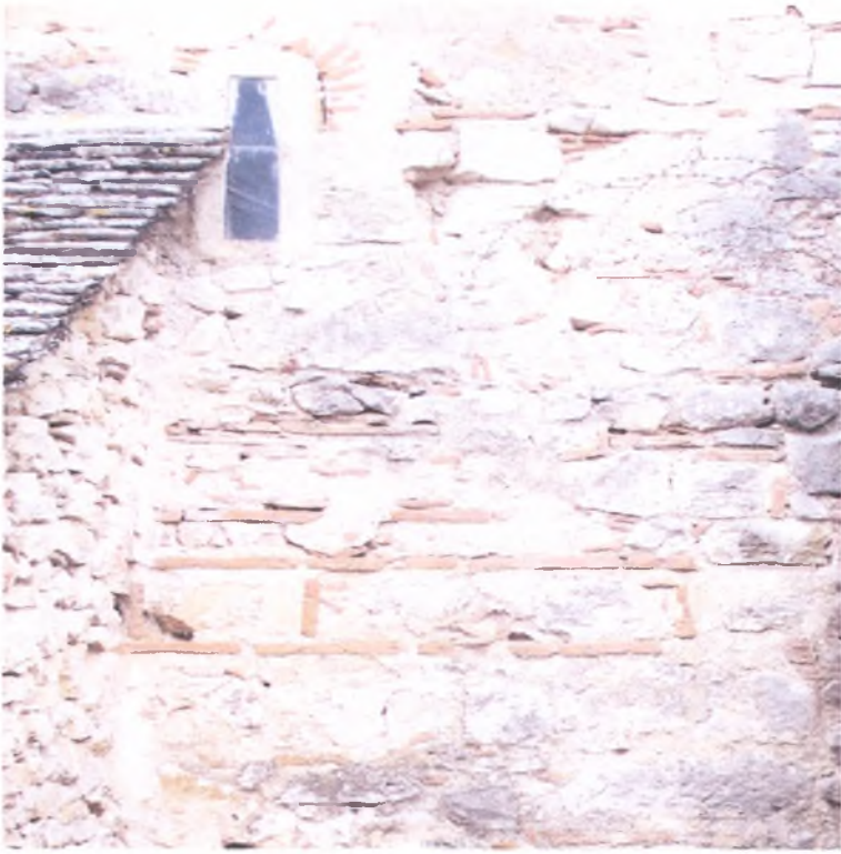
Εικ.6. Μονή Αγίου Νικολάου των Φιλανθρωπηγών. Λεπτομέρεια της τοιχοποιίας του νότιου μακρού τοίχου.
