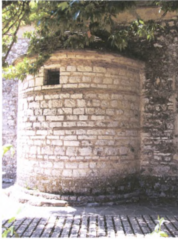
Εικ.25. Μονή Αγίου Παντελεήμονος. Άποψη του ανατολικού τοίχου.
