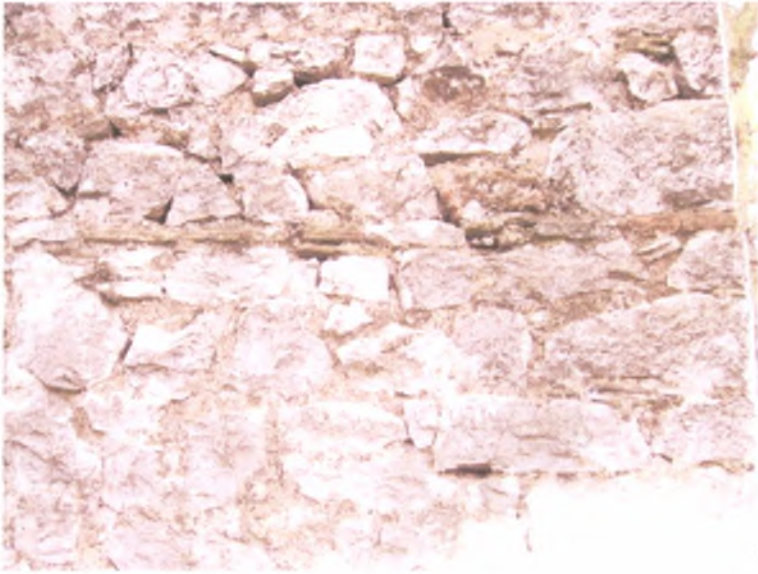
Εικ.23. Μονή Προφήτου Ηλίου. Λεπτομέρεια τοιχοποιΐας του βόρειου μακρού τοίχου.
