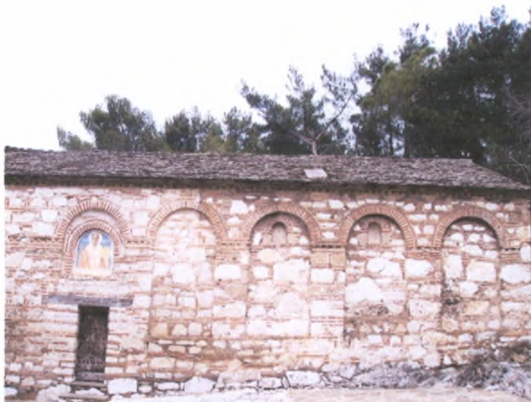
Εικ.12. Μονή Αγίου Νικολάου του Ντίλιου ή Στρατηγοπούλου. Άποψη νότιου μακρού τοίχου.
