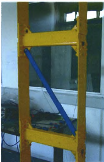
Εικόνα 3.2.1.7. Μεταλλικό στοιχείο στην κατασκευή.
