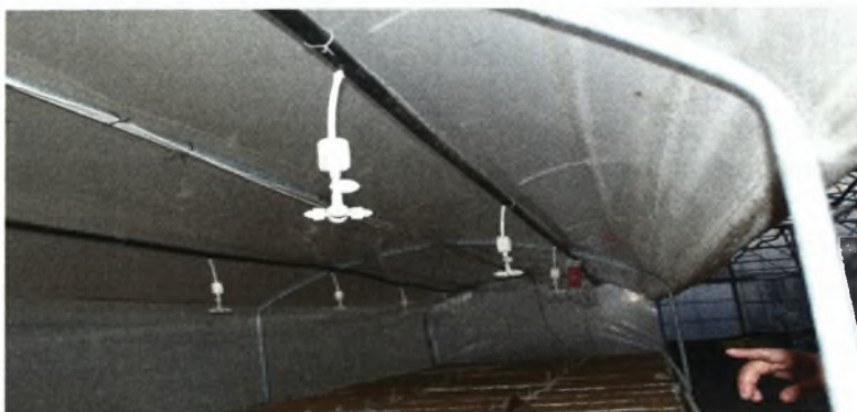
Σύστημα δημιουργίας συνθηκών υδρονέφωσης.
