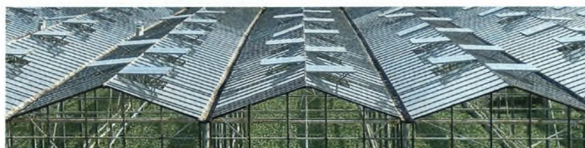
Παθητικός αερισμός μέσω των ανοιγμάτων οροφής
