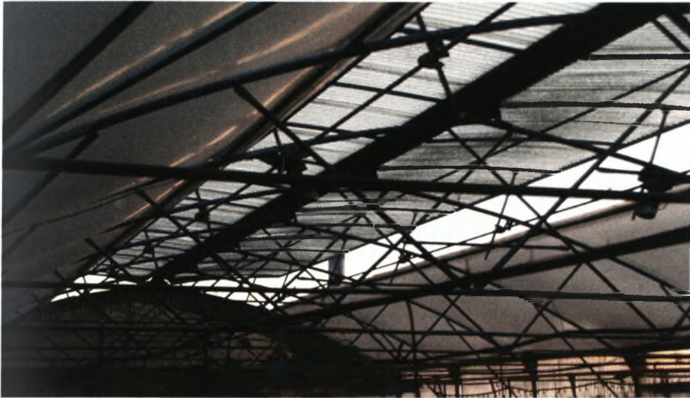
Ανοίγματα οροφής τύπου 'πεταλούδα' (γιατί ανοίγουν στο πλάι σα τα φτερά της πεταλούδας)
