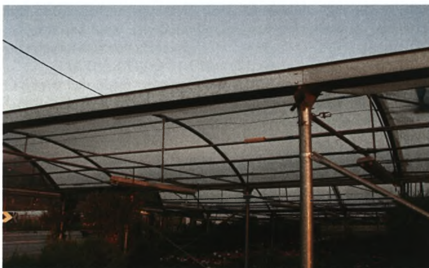
Κάλυψη θερμοκηπίου τύπου τροποποιημένου τοξωτού με πολυαιθυλένιο. Στο πλάι διακρίνονται και οι υδρορροές.
