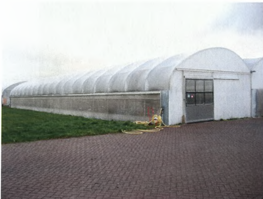
Πλαστικό θερμοκήπιο τύπου τροποποιημένου τοξωτού. (12)
