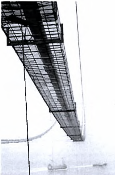
Ο βοηθητικός διάδρομος πλάτους τεσσάρων μέτρων για την κατασκευή αλλά και για τη συντήρηση στο μέλλον του βασικού καλωδίου
