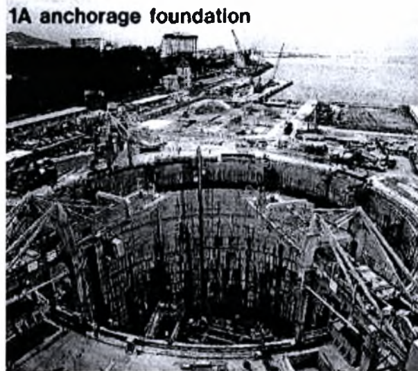
Θεμέλιο στο αγκυροβόλι 1A (αριστερά όπως βλέπουμε στην όψη)
