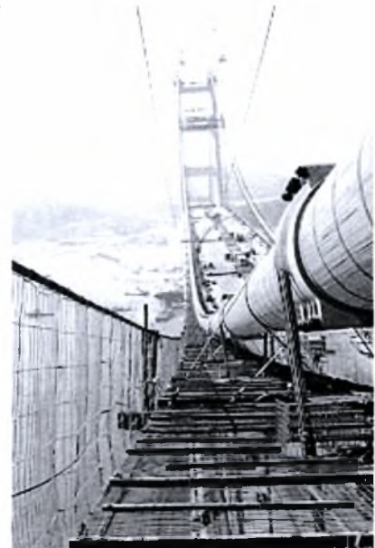
Ο βοηθητικός διάδρομος πλάτους τεσσάρων μέτρων για την κατασκευή αλλά και για τη συντήρηση στο μέλλον του βασικού καλωδίου
