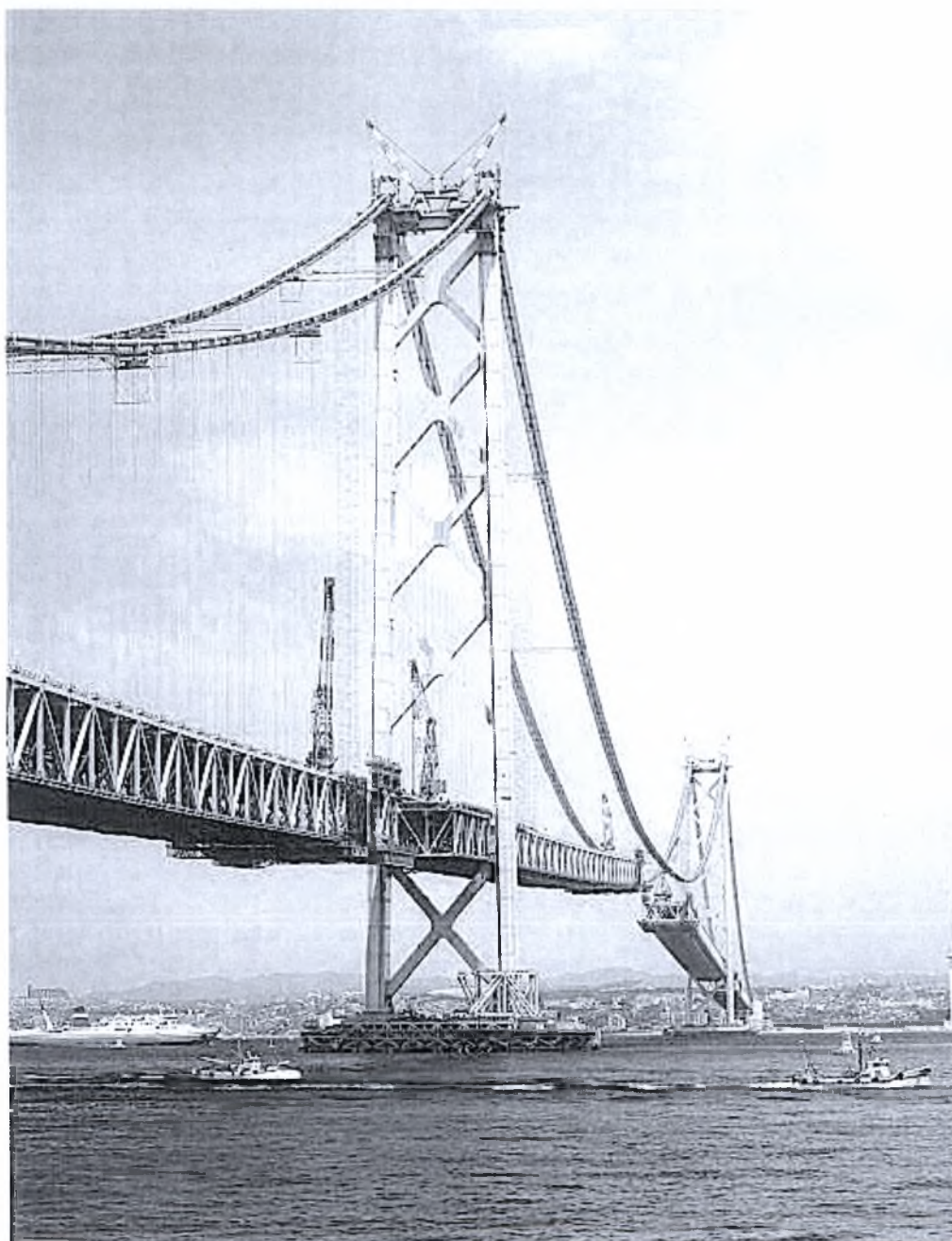
Πάνω διακρίνονται οι δυο μεταλλικές σέλες του πυλώνα όπου πατάνε τα βασικά καλώδια
