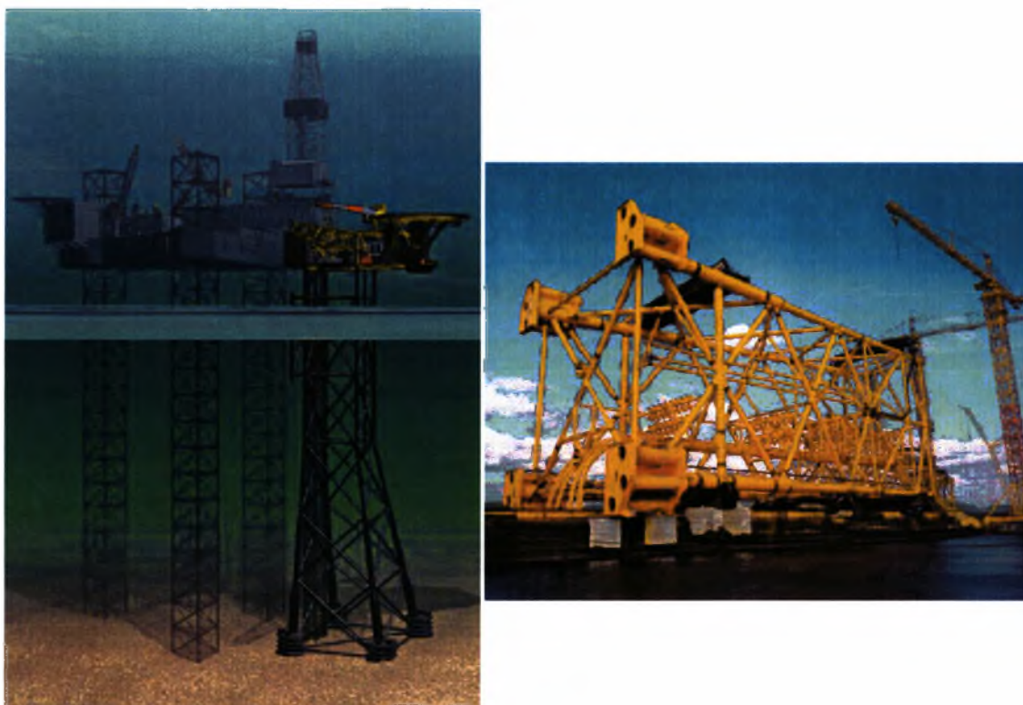
Σχήμα 1-1. Σχηματική παράσταση της εξέδρας αερίου στο Goldeneye στην Μ.Βρετανία και το δικτύωμα έτοιμο προς τοποθέτηση για την εξέδρα πετρελαίου στο Oseberg Sør στην Νορβηγία.
