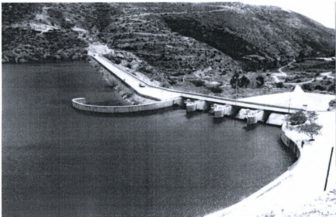
Σχήμα 2.4: Φράγμα Γερμασόγειας Κύπρου, (Υδατική Ανάπτυξη στην Κύπρο, 1996)
