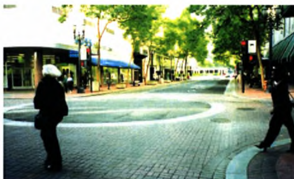
Εικόνα 7. Portland. Oregon. ΗΠΑ. Διαμόρφωση διασταύρωσης με κόκκινους κυβόλιθους και με πλάκες που σχηματίζουν έναν κύκλο στο κέντρο της. Η διασταύρωση γίνεται έτσι πιο εύκολα αντιληπτή από τα αυτοκίνητα που την προσεγγίζουν και συμβάλει θετικά στην αισθητική του δρόμου.
