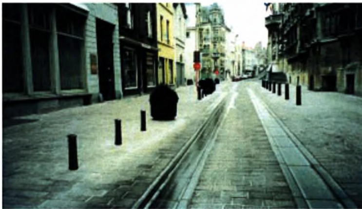
Εικόνα 10. Gent. Βέλγιο. Δύο ορθογώνιας διατομής αυλάκια που καταλήγουν σε σχάρες απορροής των όμβριων σε μοντέρνα διαμόρφωση στο ιστορικό κέντρο της πόλης. Πηγή: Βλαστός, και Μπιρμπίλη, 2001, σελ. 41.
