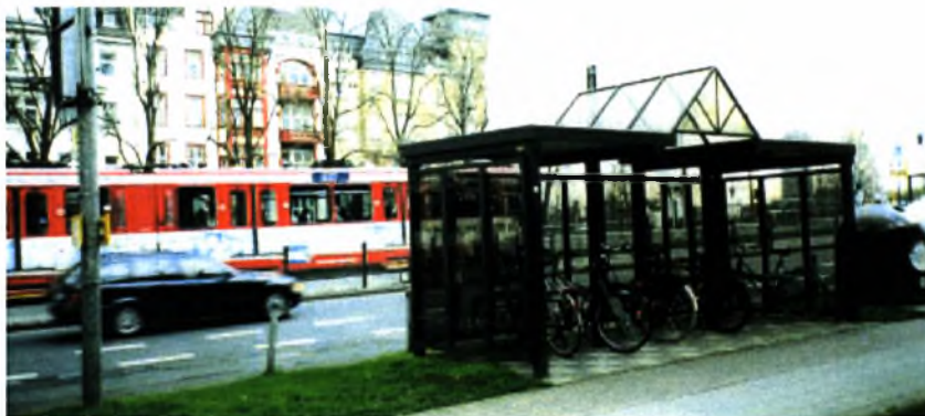
Εικόνα 26. Düsseldorf. Γερμανία. Χώρος στάθμευσης ποδηλάτων σε στάση τραμ που κινείται στον άξονα της οδού.
