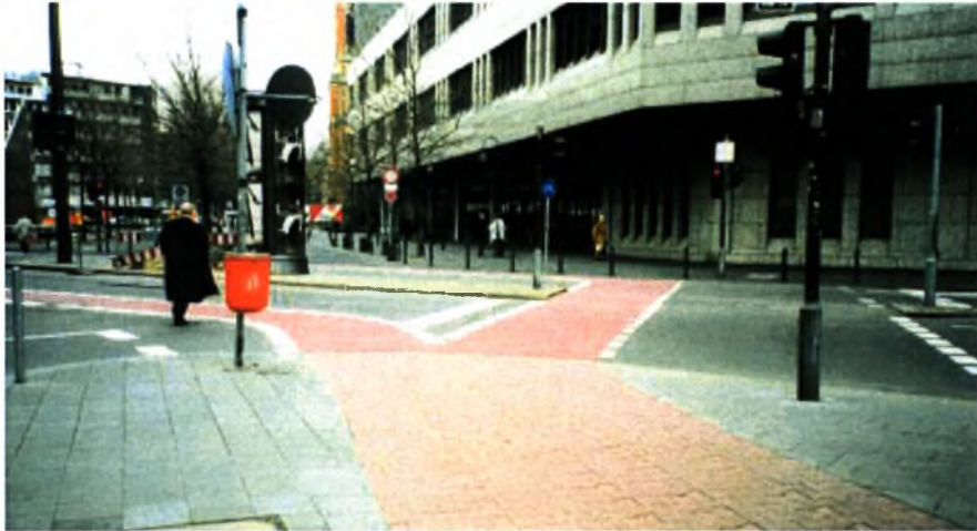
Εικόνα 9. Düsseldorf. Γερμανία. Παράδειγμα από αστική περιοχή. Κόκκινοι κυβόλιθοι για τη σήμανση λωρίδας ποδηλάτου σε πλακοστρωμένο πεζοδρόμιο. Πηγή: Βλαστός και Μπιρμπίλη, 2001, σελ. 101.
