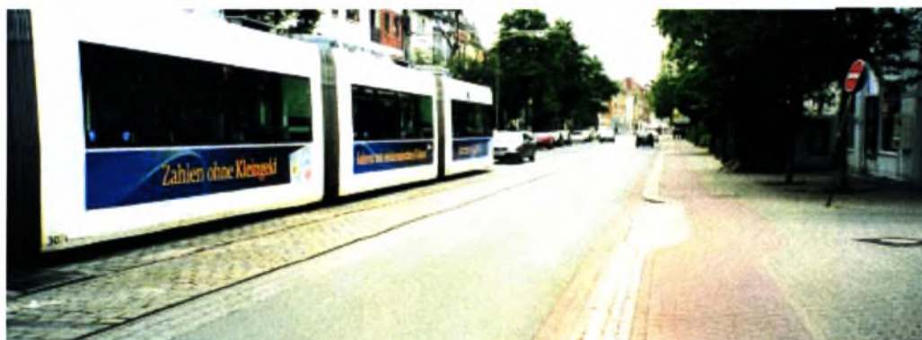
Εικόνα 8. Bremen. Γερμανία. Στη Βρέμη, συστηματικά, οι λωρίδες ποδηλάτου έχουν κατασκευαστεί επί των πεζοδρομίων. Εδώ φαίνεται η διέλευση ποδηλατοδρόμου από διασταύρωση με δρόμο υποδεέστερου ρόλου. Η λωρίδα του ποδηλάτου και το πεζοδρόμιο δεν διακόπτονται στη διασταύρωση και διατηρούν τη στάθμη τους. Ο ποδηλατοδρόμος κάμπτεται για δύο λόγους: πρώτον, για να υπάρξει χώρος για την κατασκευή της ράμπας και δεύτερον, για να υποχρεωθεί ο ποδηλάτης να μειώσει ταχύτητα στην περιοχή της διασταύρωσης.
