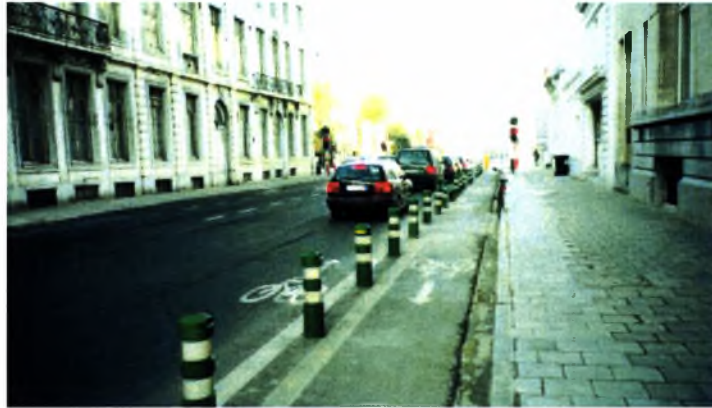
Εικόνα 2. Bruxelles. Βέλγιο. Πλαστικά κολωνάκια για την προστασία λωρίδας ποδηλάτου για κίνηση contra-flow. Η ομόρροπη, με τα αυτοκίνητα, κίνηση του ποδηλάτου γίνεται στον ίδιο χώρο με αυτά.
