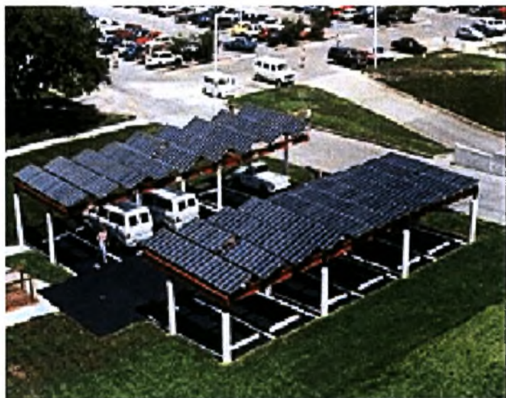
Εικόνα 71: Μορφή σταθμού επαναφόρτισης ηλεκτρικών οχημάτων με φωτοβολταϊκά Πηγή: http://website.lineone.net/~simon.h.roberts/talks/e+p/images/ev_charging.jpg
