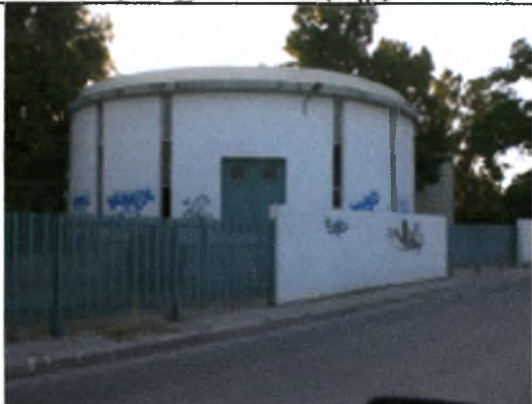
Εικόνα 20: Κεντρικό αντλιοστάσιο ακαθάρτων Λαρίσης – Αλαμάνας
