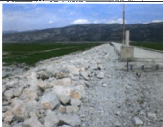
Εικόνα 3: Λίμνη Κάρλα. Αποψη αναχώματος.
