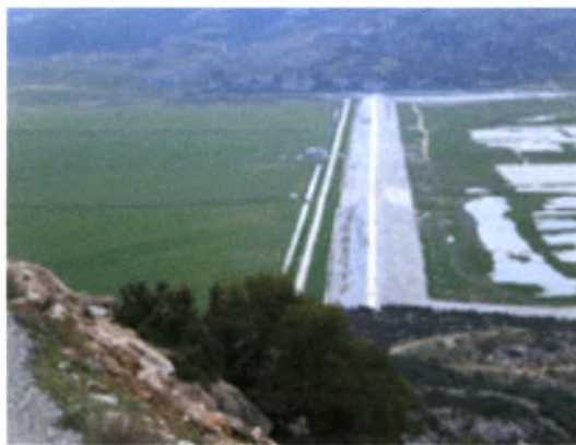
Εικόνα 7: Λίμνη Κάρλα. Ανατολικό ανάχωμα.
