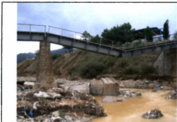
Εικόνα 34: Χείμαρρος Ξηριάς. Πλημμύρα Οκτωβρίου 2006. (Πηγή ΟΣΕ Βόλου).
