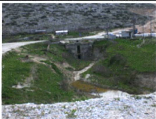
Εικόνα 2: Λίμνη Κάρλα. Είσοδος σήραγγας εκτόνωσης.
