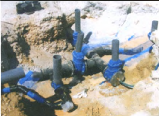
Εικόνα 16: Κόμβος νέου δικτύου ΔΕΥΑΜΒ. (Πηγή ΔΕΥΑΜΒ).
