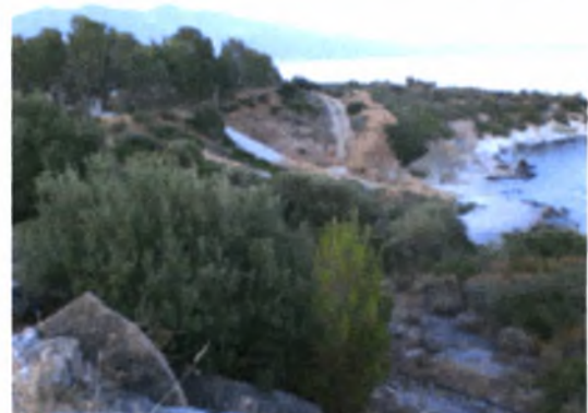
Εικόνα 25: Είσοδος αγωγού διάθεσης επεξεργασμένου ύδατος από ΕΕΛ στη θάλασσα, στη περιοχή Αγκίστρι
