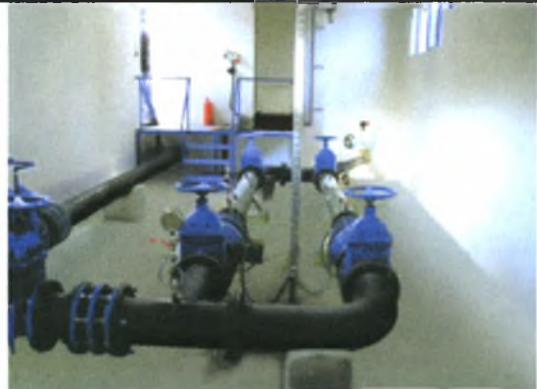
Εικόνα 17: Σταθμός αυτομάτου ελέγχου ΔΕΥΑΜΒ. (Πηγή ΔΕΥΑΜΒ).
