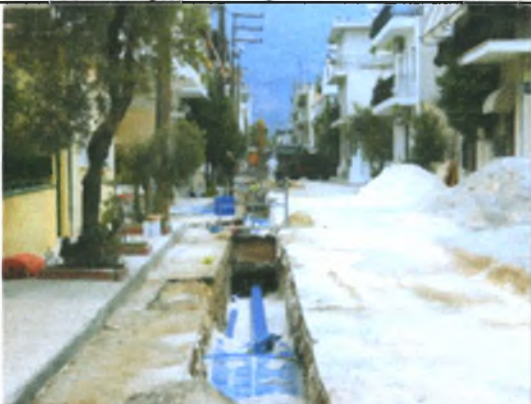
Εικόνα 14: Αντικατάσταση παλαιού δικτύου ΔΕΥΑΜΒ. (Πηγή ΔΕΥΑΜΒ).
