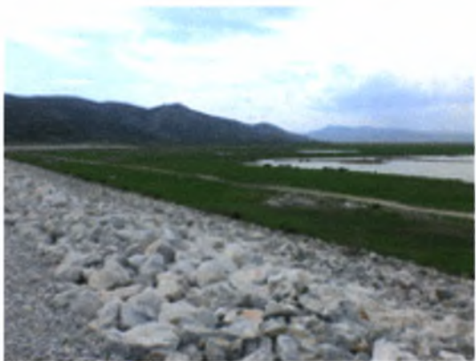
Εικόνα 6: Λίμνη Κάρλα. Θέα από στέψη αναχώματος.
