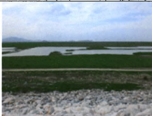
Εικόνα 5: Λίμνη Κάρλα. Θέα από στέψη αναχώματος.
