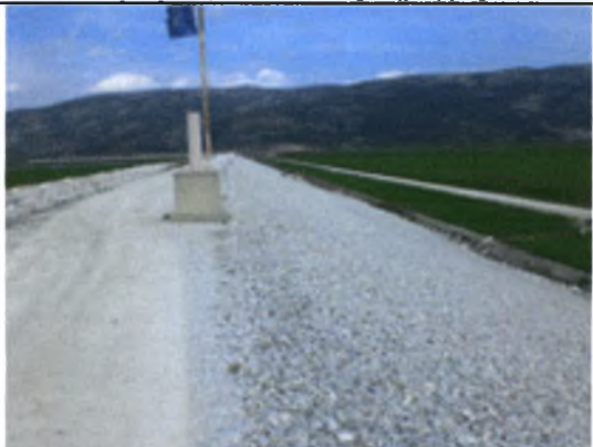
Εικόνα 4: Λίμνη Κάρλα. Στέψη αναχώματος.
