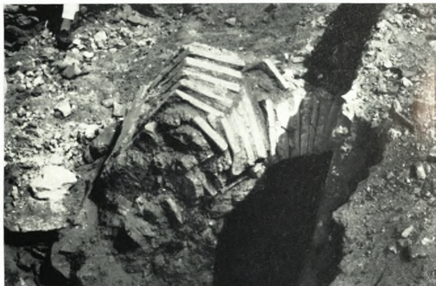
β. Τμήμα πλινθοκτίστου γενέσεως τόξων.
