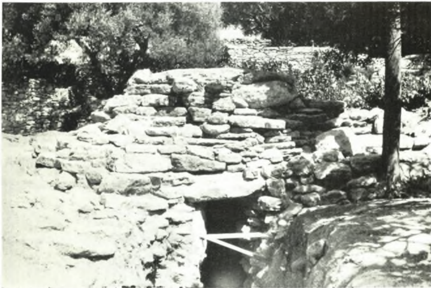
β. Ὁ θολωτὸς τάφος Α μετὰ τὰς ἐργασίας ἀποκαταστάσεως αὐτοῦ.
