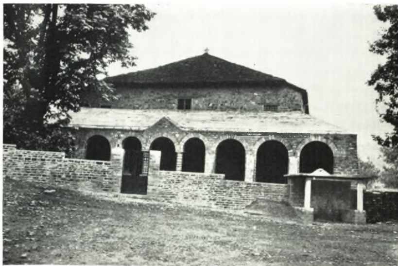
β. Ἡ Δ. στοῦ τοῦ Ἁγ. Γεωργίου Νεγάδων μετὰ τὴν ἀναστήλωσιν.
