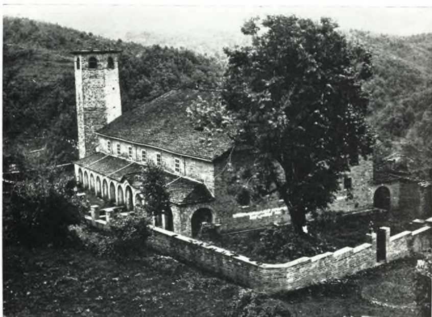
α. Ὁ ναός τοῦ Ἁγ. Γεωργίου Νεγάδων ἀπὸ ΒΑ. πρὸ τῶν ἐργασιῶν ἀποκατάστασως τῆς ἐξωτερικῆς κιονοστοιχίας.
