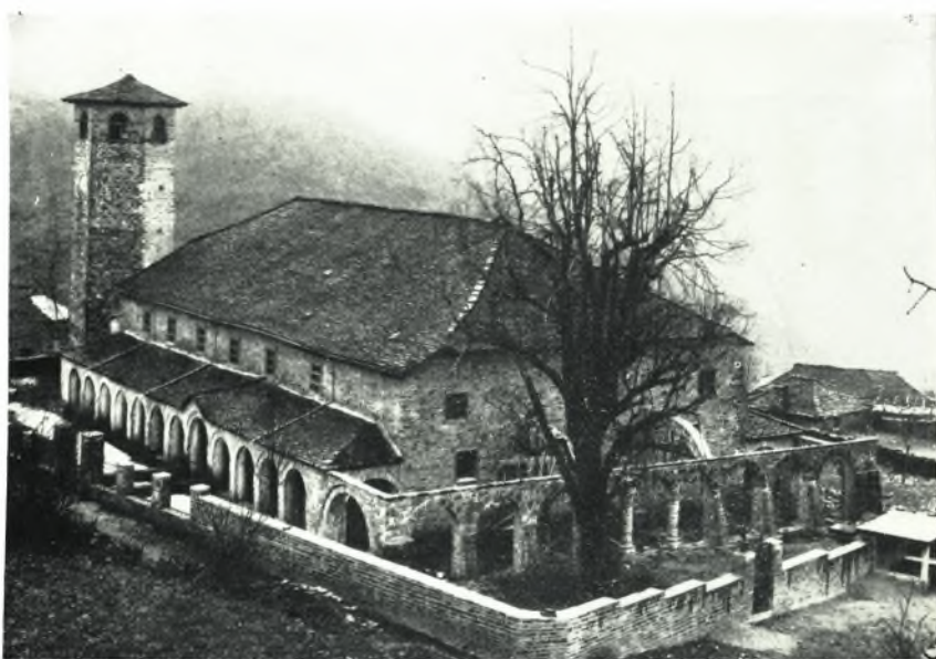
β. Ὁ ναός τοῦ Ἁγ. Γεωργίου Νεγάδων ἀπὸ ΒΑ. μετὰ τὴν ἀποκατάστασιν τῆς ἐξωτερικῆς δυτικῆς κιονοστοιχίας.
