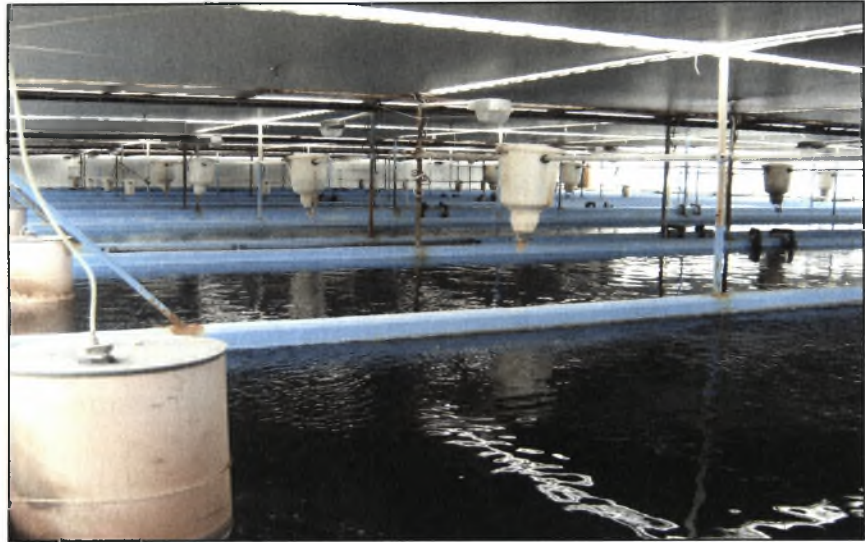
Εικόνα 6: Τσιμεντένιες δεξαμενές προπάχυνσης ορθογωνίου σχήματος. Διακρίνονται τα στέγαστρα για την προστασία των ιχθυδίων από την ηλιακή ακτινοβολία και οι εγκαταστάσεις της αυτοματοποιημένης διανομής τροφής. (Πηγή: Προσωπικό αρχείο).
