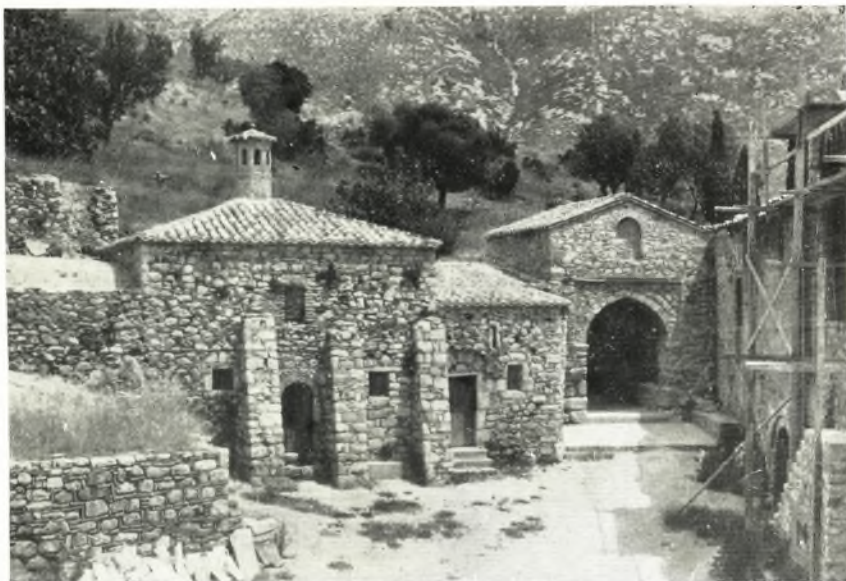
α. Ἀποψις τοῦ πυλῶνος καὶ τοῦ φωτανάματος ἐκ τοῦ ἐσωτερικοῦ τῆς μονῆς μετὰ τὰς ἐργασίας ἀναστηλώσεως.
