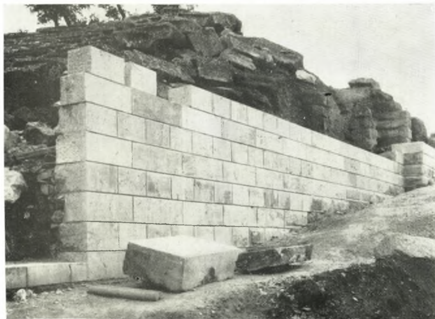
α. β. Τὸ Δ. ἀνάλημμα τοῦ θεάτρου τῆς Ἐπιδαύρου πρὸ καὶ μετὰ τὰς ἐργασίας ἀναστηλώσεως.
