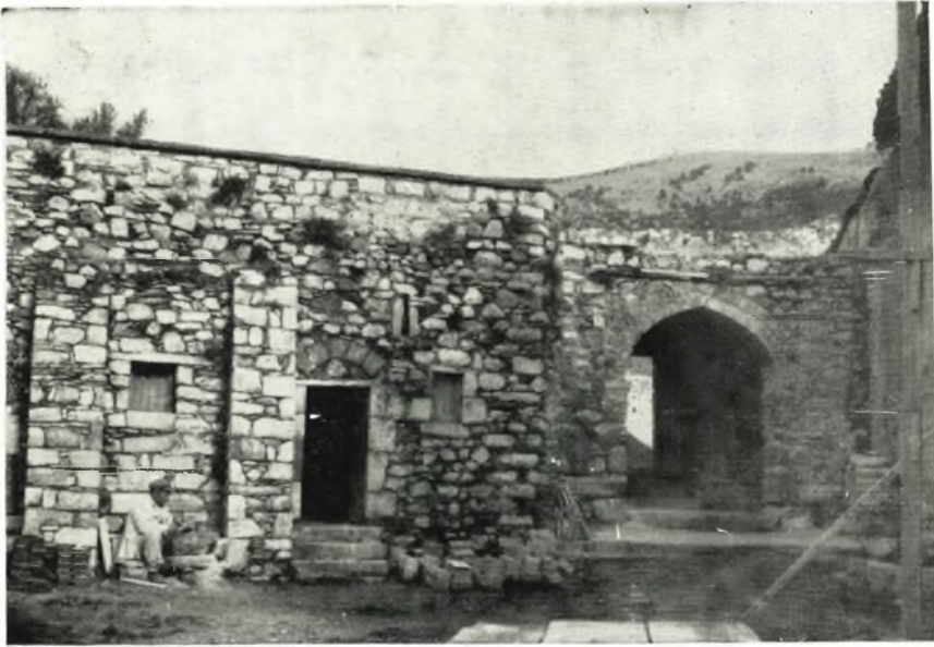
α. Ἀποψις τοῦ πυλῶνος καὶ τοῦ φωτανάματος ἐκ τῆς αὐλῆς τῆς μονῆς Ὁσίου Λουκά πρὸ τῶν ἐργασιῶν ἀναστηλώσεως.
