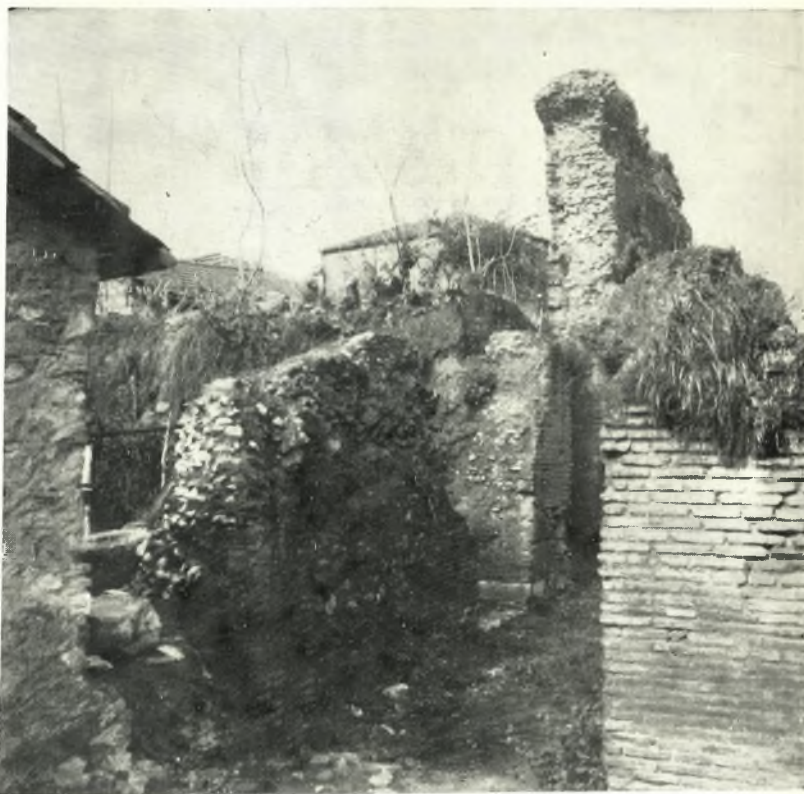
α. Οί εξωτερικοί τοίχοι του Ὀδείου Πατρῶν πρὸ τῶν ἐργασιῶν ἀναστηλώσεως
