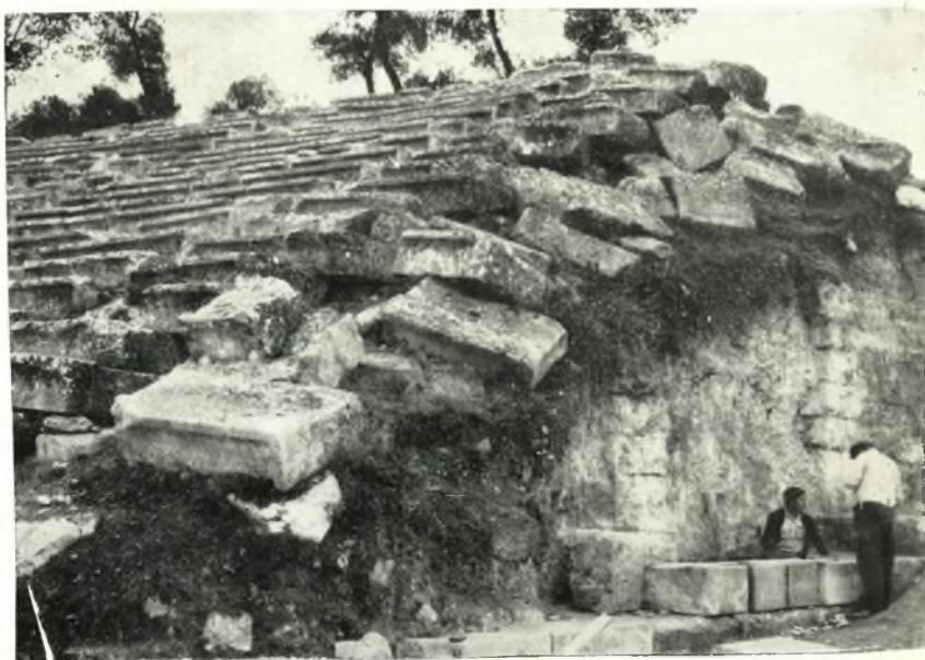
β. Τὸ Δ. ἀνάλημμα τοῦ ἄνω διαζώματος τοῦ θεάτρου τῆς Ἐπιδαύρου πρὸ τῆς ἀναστηλώσεως.
