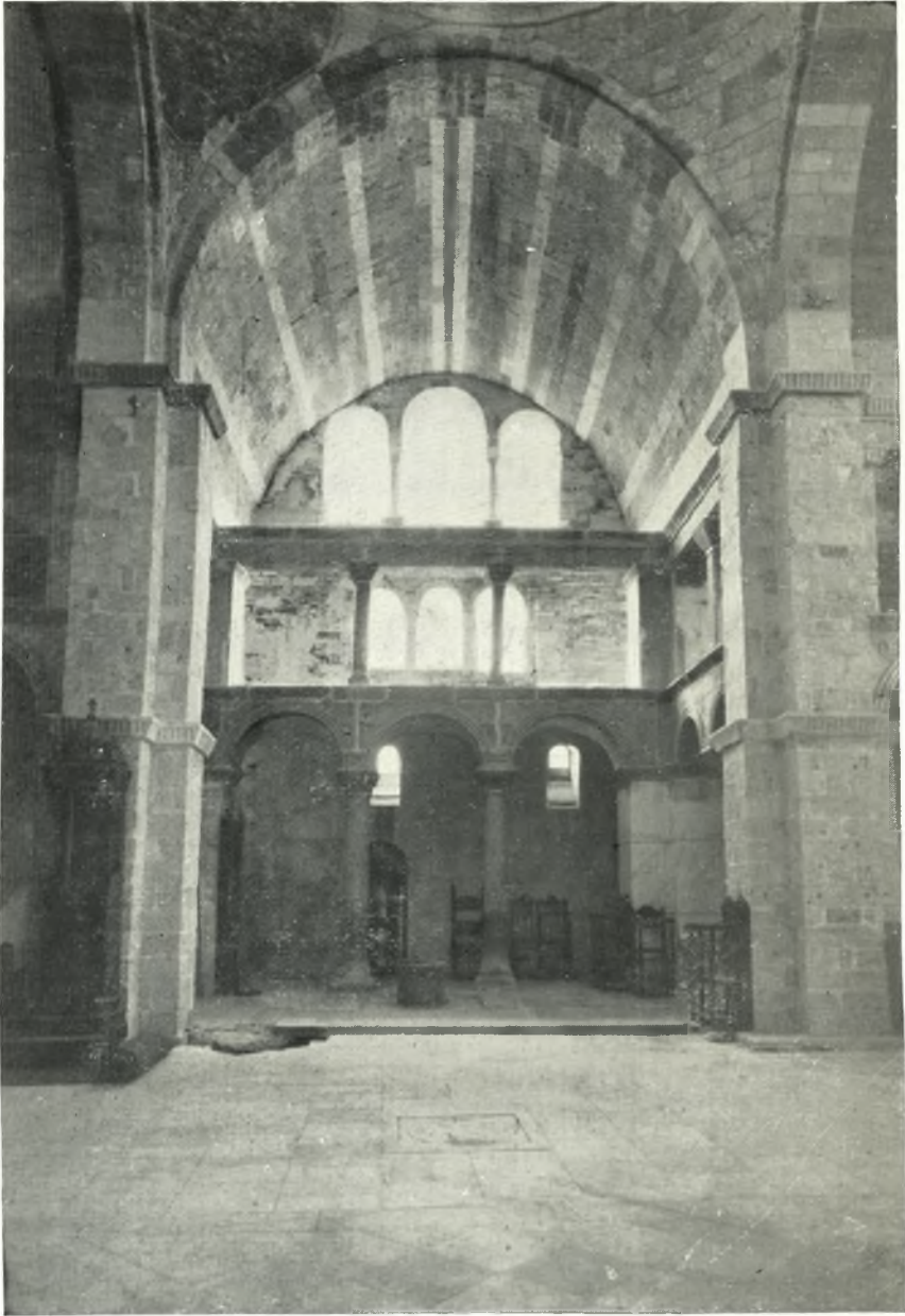
*Αποψις τοῦ ἐσωτερικοῦ τοῦ νοτίου σκέλους τοῦ σταυροῦ τῆς Καταπολιανῆς δεικνύουσα τὸ ἀνοιχθὲν μέγα τρίλοβον παράθυρον καὶ τὰς τριχρόμους σειρὰς θολιτῶν τῆς καμάρας.
