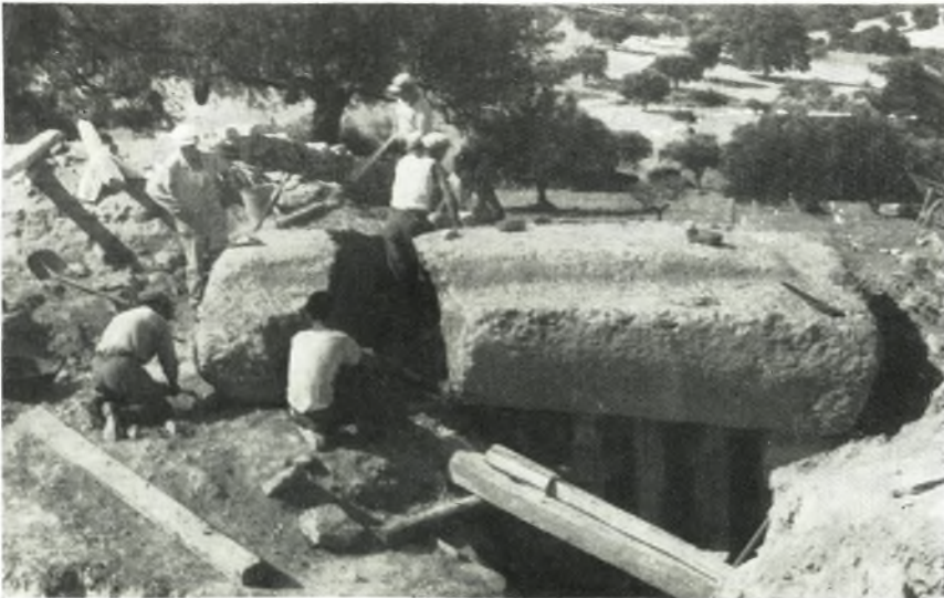
β. Ἀνώφλιον τοῦ τ. 1 κατὰ τὴν διάνοιξιν τῆς ρωγμῆς ὑπὸ τῆς Ὑπηρεσίας Ἀναστηλώσεως.
