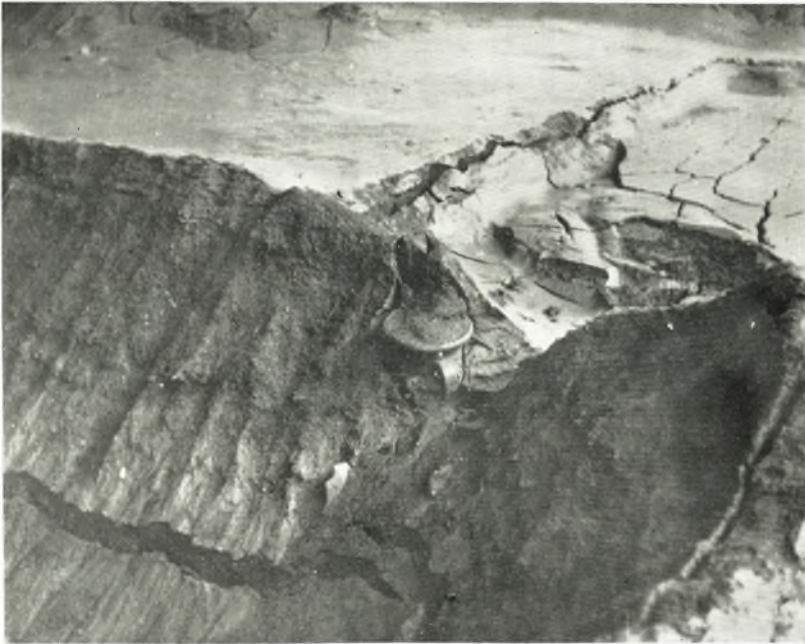
α. Ἡ καταστροφή τῆς Ἱερᾶς Οἰκίας μετὰ τὴν θεομηνίαν τοῦ Νοεμβρίου τοῦ 1961.
