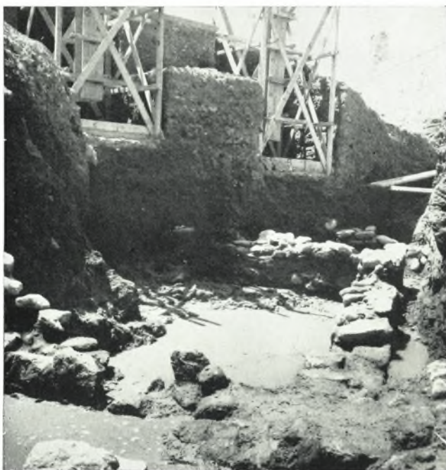
α. Τὰ ἀνασκαφέντα οἰκοδομήματα ὑπὸ τοὺς ξυλοτύπους τοῦ ὑπὸ ἀνέγερσιν Εἰρηνοδικείου Νάξου.
