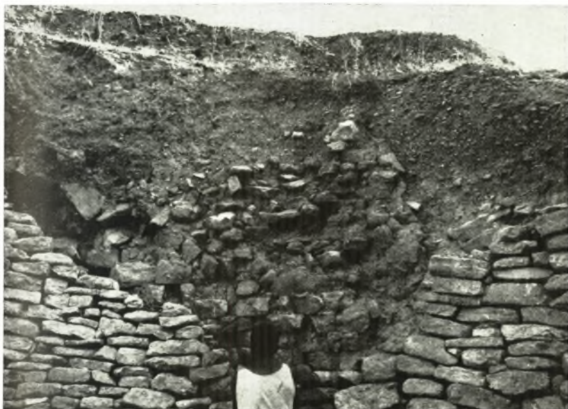
α. Περιστεριά, θ. τ. 1. Κατάσταση των τοιχωμάτων της θόλου (κέντρον) και άμεσος επένδυσις τούτων διά ξηροτοίχου.
