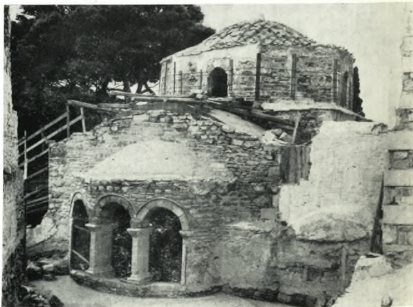
β. Ἡ ἀψίς τοῦ ἱεροῦ τοῦ Βαπτιστηρίου μετὰ τὴν ἀναστήλωσιν αὐτῆς.
