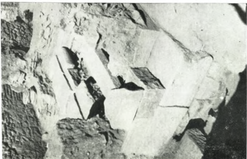
α. Σύστημα ἰσοδύμου τοιχοδομίας κατὰ τὴν Β.Α. γωνίαν τοῦ λουτροῦς.
