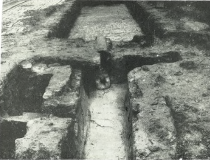
β. Τὸ στόμιον ἐκκενώσεως τῆς δεξαμενῆς εἰς σχῆμα ἀνεστραμμένου Π καὶ ἄνωθεν αὐτοῦ ἐκχειλιστὴρ τραπεζοειδοῦς τομῆς (πρβ. τὴν ἀνωτέρω εἰκόνα).
