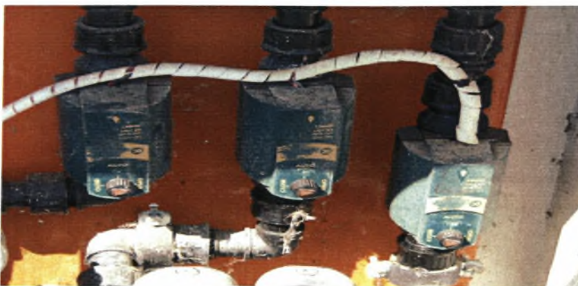
Εικόνα 4.4. Ηλεκτροβάνες άρδευσης
